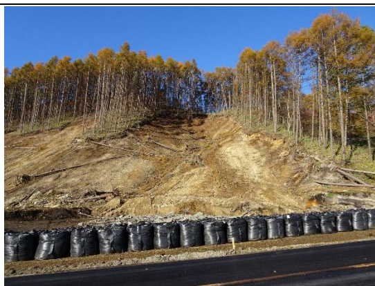
胆振東部地震による斜面崩壊の例 左：厚真町幌内地区 右：厚真町吉野地区 いずれも谷部が崩壊していることがわかる。
