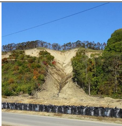
胆振東部地震による斜面崩壊の例 左：厚真町幌内地区 右：厚真町吉野地区 いずれも谷部が崩壊していることがわかる。
